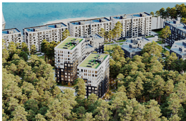
ЖК «Флора и Фауна» г. Новосибирск, 2018-2019 г.г.
