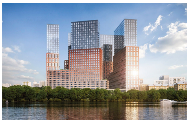
ЖК «Level Причальный» г. Москва, 2022 г.
